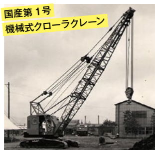
国産第1号 機械式クローラクレーン 石川島コーリング(現・加藤製作所) 330 スプローラクローラクレーン(1952) 石川島重工業が米国・コーリング社と技術提携、設立した石川島コーリングが製造した機械式クレーン。
