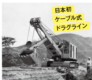
日本初 ケーブル式 ドラグライン 日立製作所(現・日立建機) UO5 ショベル(1949)
