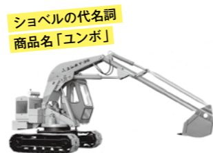
ショベルの代名詞 商品名「ユンボ」 新三菱重工業(現・キャタピラー) ユンボ Y35 油圧ショベル(1961) フランス・シカム社と技術提携した新三菱重工業が国産化。現在でもショベルを「ユンボ」と呼ぶ人が多い。
