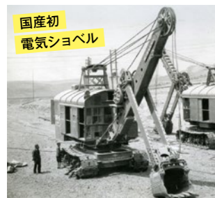
国産初 電気ショベル 神戸製鋼所(現・コベルコ建機) 50K 電気ショベル(1930) 1.5㎡。
