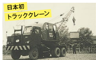
日本初 トラッククレーン 神戸製鋼所(現・コベルコ建機) 10KT トラッククレーン(1953) 10KT(6t)とともに20KT(10t)を完成させ、警察予備隊へ納入。
