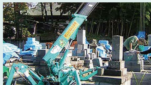
墓石の吊り上げ作業の様子
