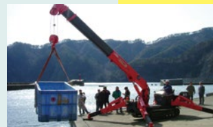
ミニ・クローラークレーンを用いての船の積み降ろし作業の様子(宮城県石巻市牡鹿漁業協同組合)
