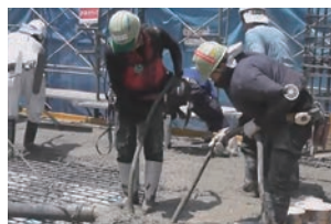
建設現場での打設作業
