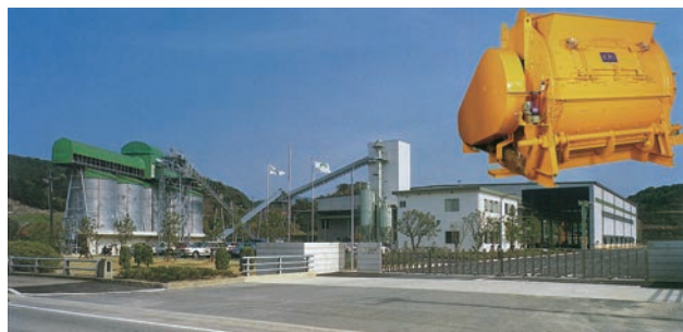
クリハラ コンクリートプラント
