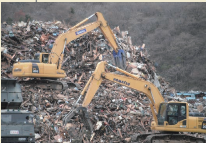
東日本大震災の被災地で活動する建設機械
